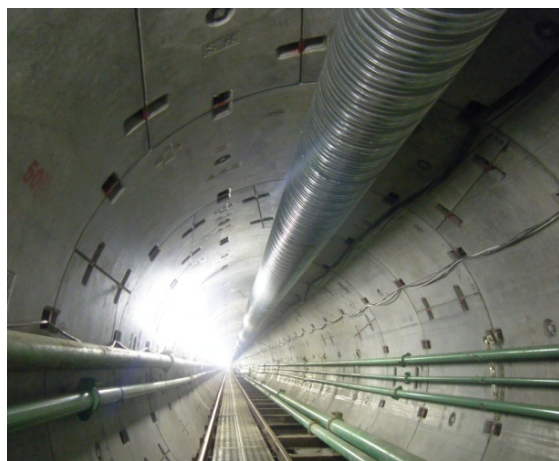
写真-1 一次覆工状況
