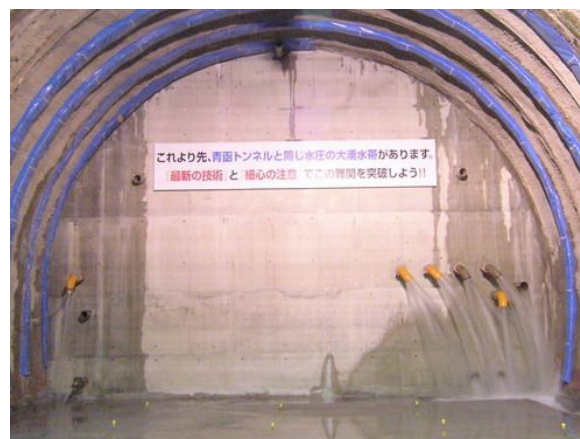
写真-3 バルクヘッド湧水状況(6t/分)
