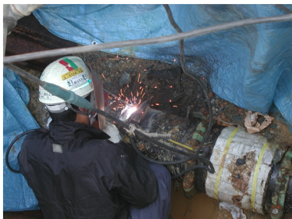
写真-2 計測対象鋼管の補修状況
