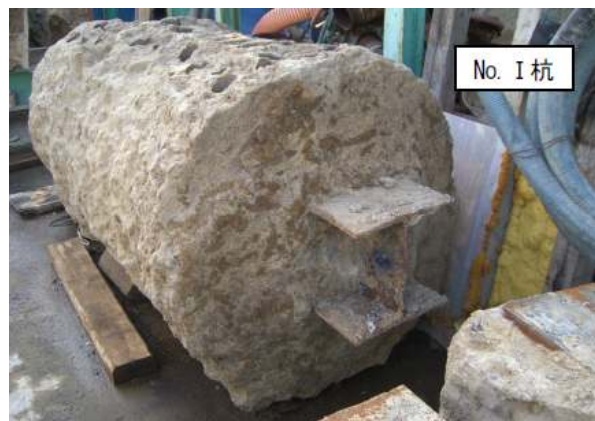
写真-5 改良体・H形鋼芯材状況
