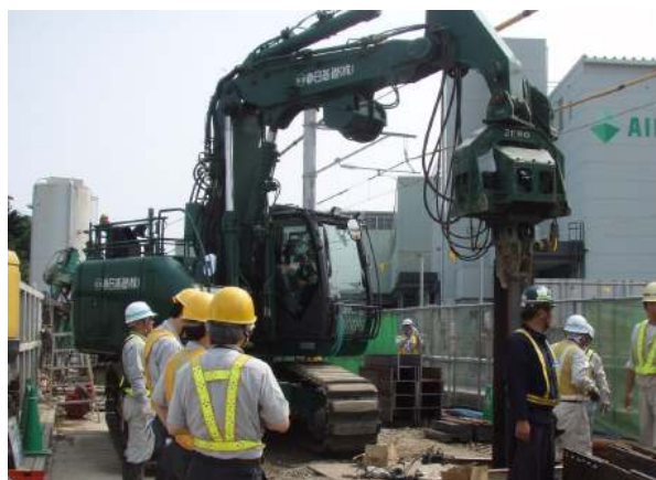
写真-3 H形鋼挿入状況
