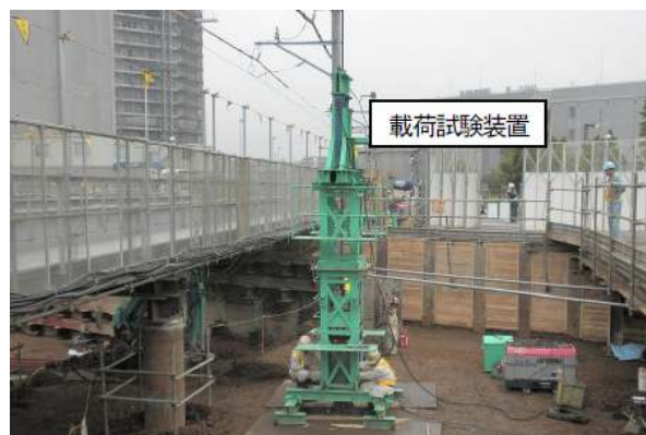
写真-6 急速載荷試験状況
