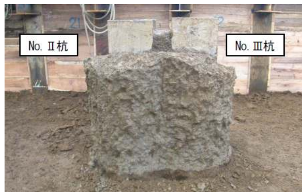
写真-4 改良体ラップ状況
