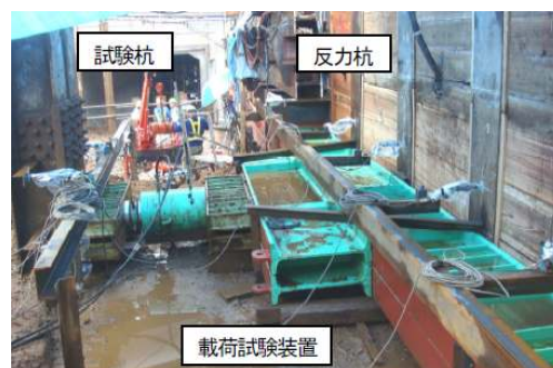
写真-7 水平載荷試験装置
