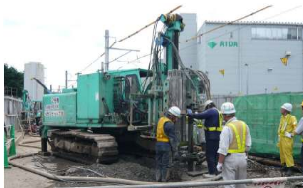
写真-1 地盤改良施工機械
