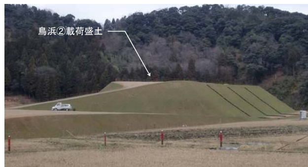
写真-3 鳥浜②載荷盛土の全景
