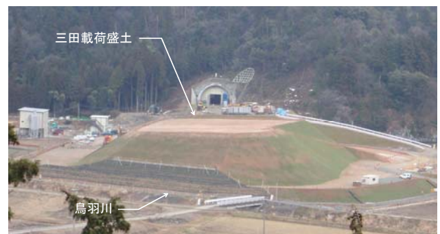
写真-2 三田载荷盛土の全景
