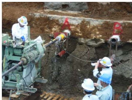
図-5 試験施工状況
