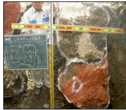
図-6 改良体出来形(特殊ロッドあり)
