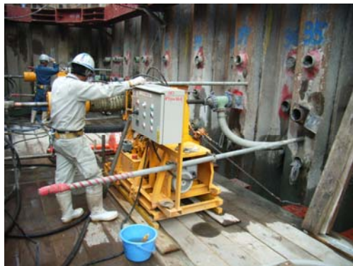
図-11 実施工状況
