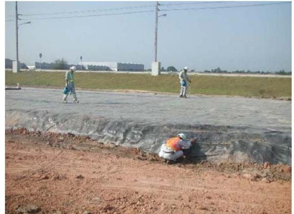
写真-4 気密シート漏気チェック状況
