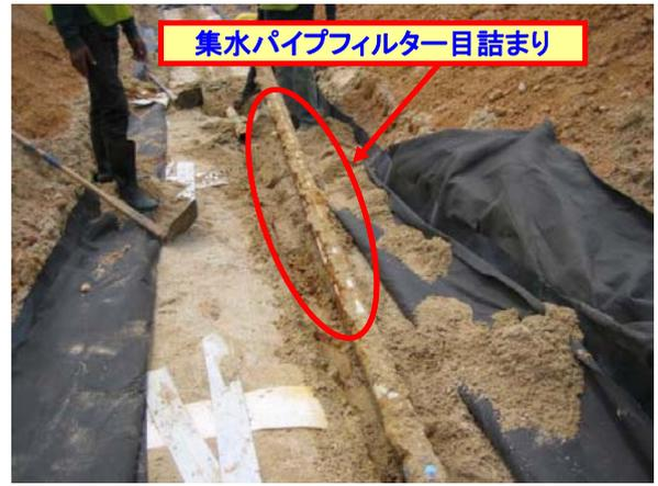
写真-3 集水管孔部目詰まり状況
