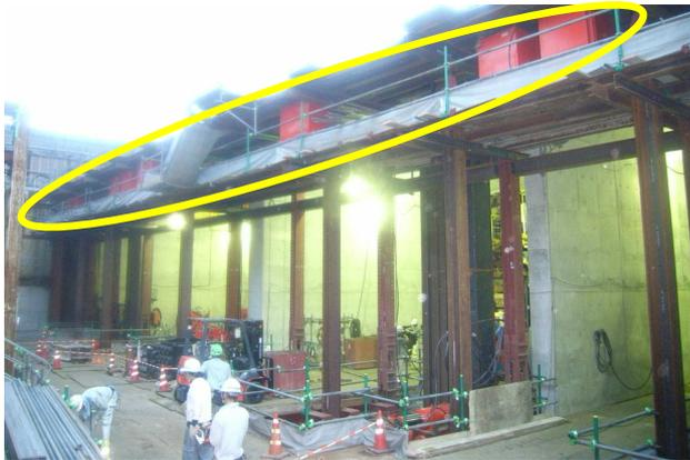
写真-11 油圧ユニット架台
