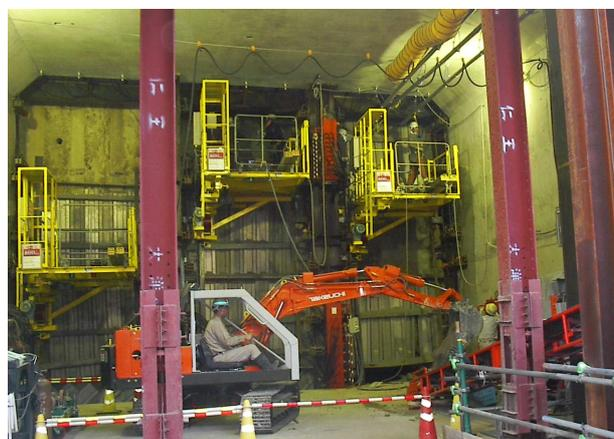
写真-10 電動バックホウ使用状況
