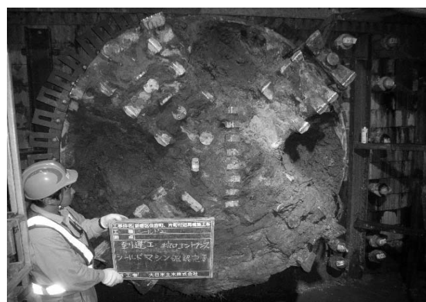
写真-7 DO-Jet シールド到達状況
