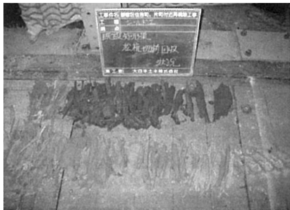
写真-6 松杭片回収状況
