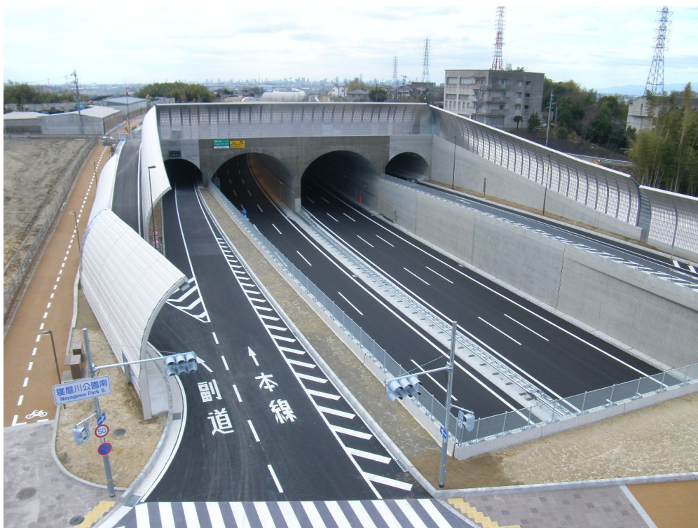
写真-2 4連アーチカルバート施工完了
