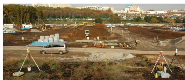
TS（左下）およびGPS基地局（右下）の配置（締固め重機：画面中央やや左）
