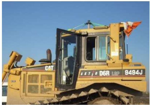
写真-3 プリズムの設置状況
