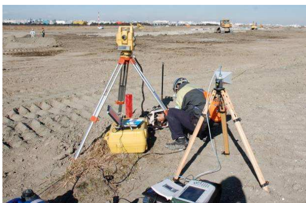
写真-5 電波環境計測状況
