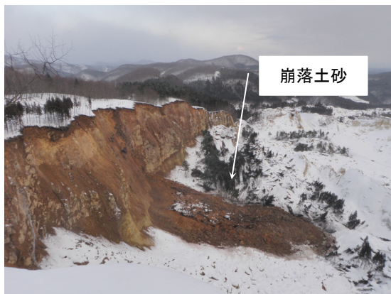
写真-3 東側斜面の崩落
