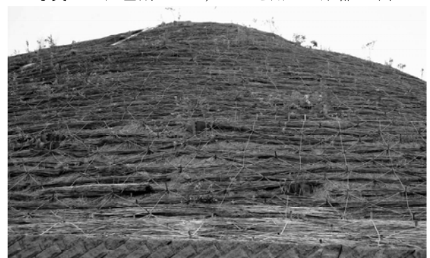
写真-6 ヨシによる法面保護工と苗木による森づくり
