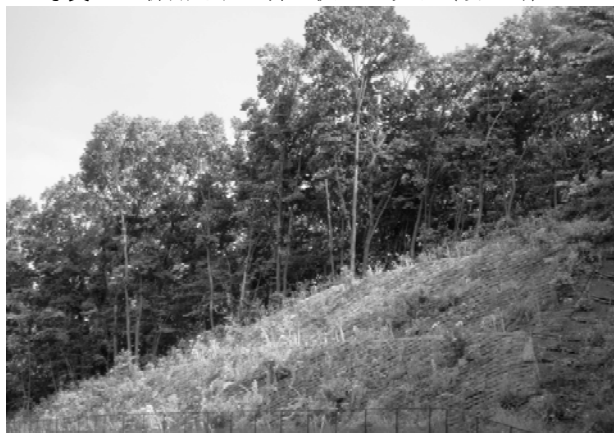
写真-12 切土法面の状況（15ヶ月経過時）
