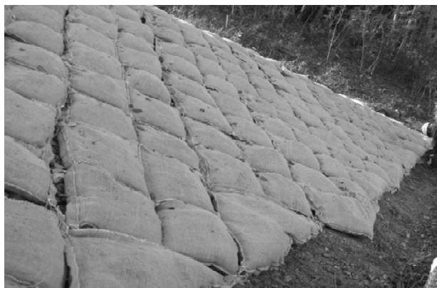
写真-11 採用された押し伏せマット（竣工時）
