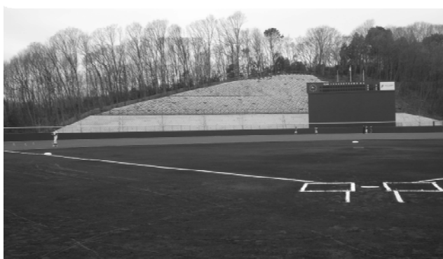
写真-10 グラウンド内から法面を見る
