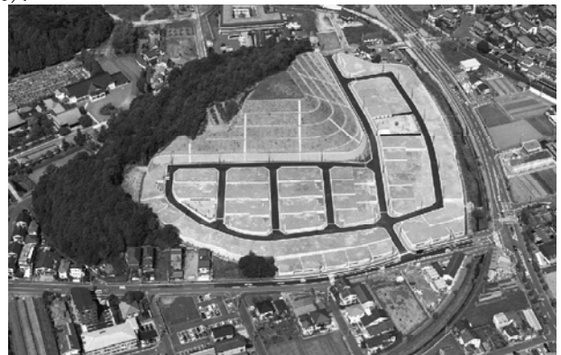
写真-4 京都一条山宅地開発プロジェクト
