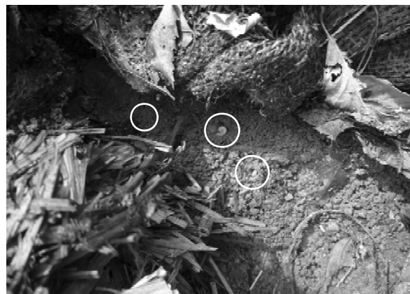
写真-14 採用された押し伏せマット（竣工時）
