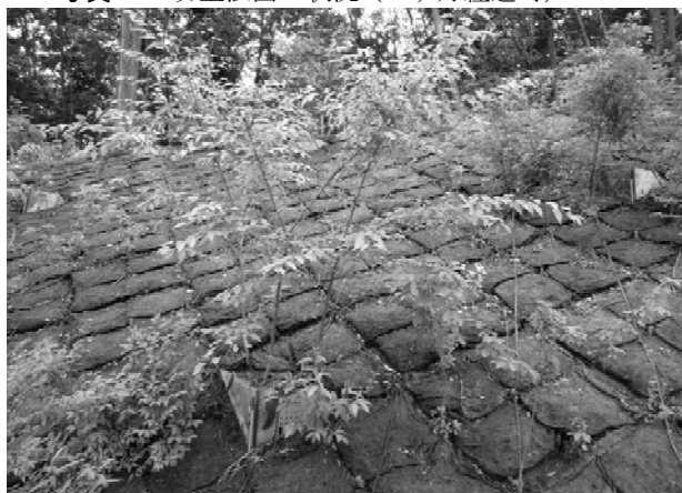
写真-13 法面保護工の状況（15ヶ月経過時）
