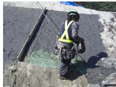
写真-7 施工状況
