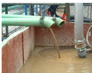
写真-3 濁水の原水槽への流入
