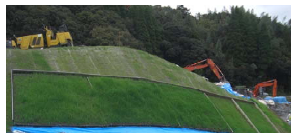
写真-9 施工2か月後の法面の緑化状況
