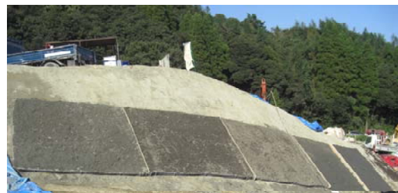
写真-8 施工直後の法面の状況
