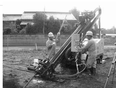
写真-1 削孔状況
