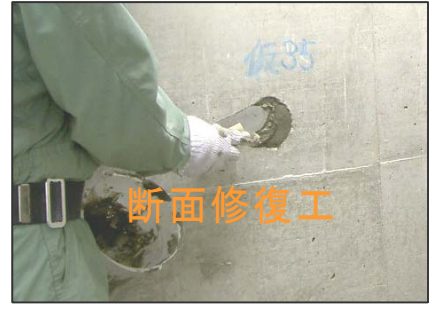
写真-8 断面修復
