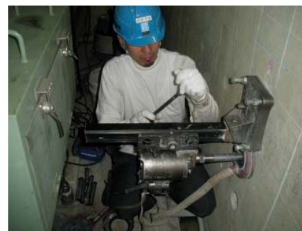
写真-5 狭隘部の施工状況
