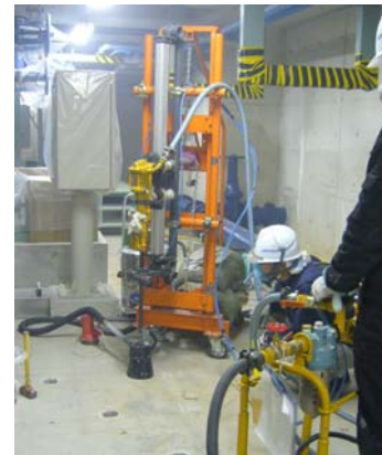
写真-4 下向き施工状況
