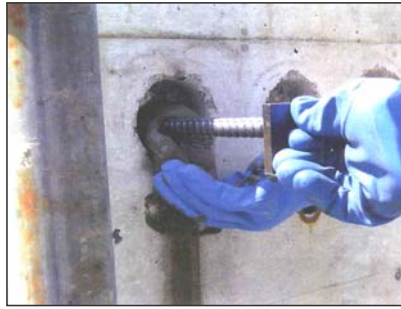
写真-7 Post-Head-bar の挿入
