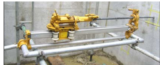
写真-3 削孔機械 (ベンチャードリル)
