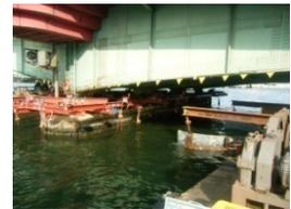
写真-4 台船から吊装置へ
