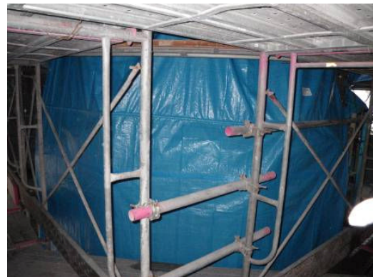
写真-3 シート養生
