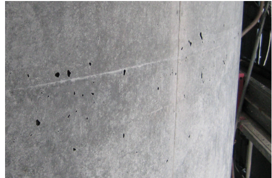
写真-2 コンクリート表面の状況
