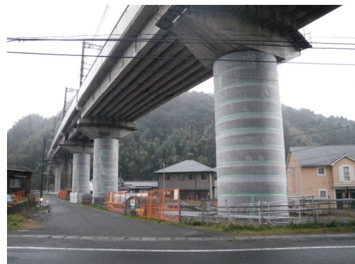
写真-4 気泡シート養生
