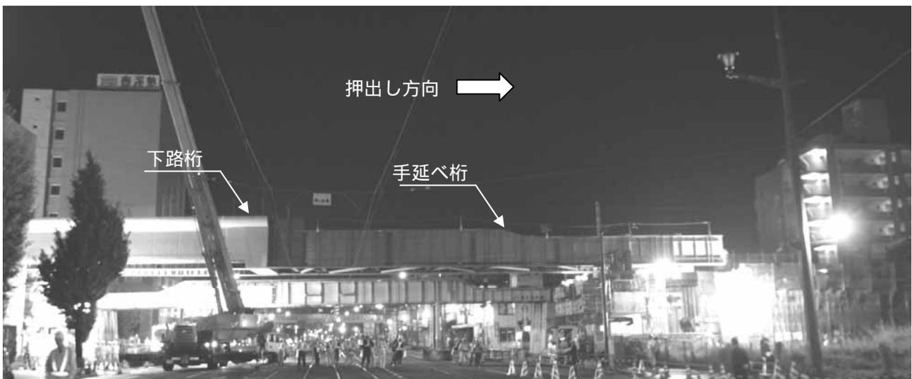
写真-4 押し出し架設状況
