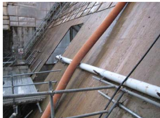
写真-7 養生撤去後の堤体下流面(接写)
