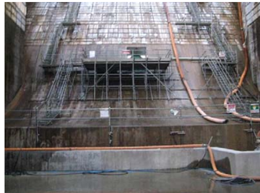
写真-6 養生撤去後の堤体下流面(全景)
