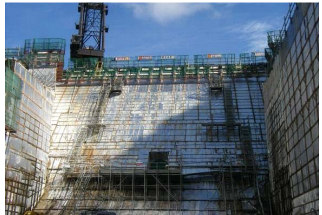
写真-4 下流面養生状況全景
