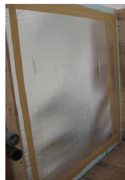
写真-5 高断熱養生シート貼付け状況
