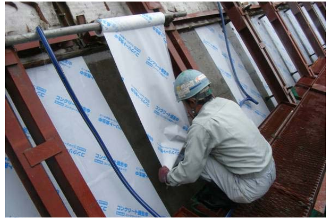
写真-2 保水テープ貼付け状況
