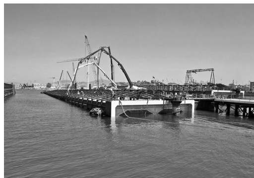
写真-6 浮上打設の状況
