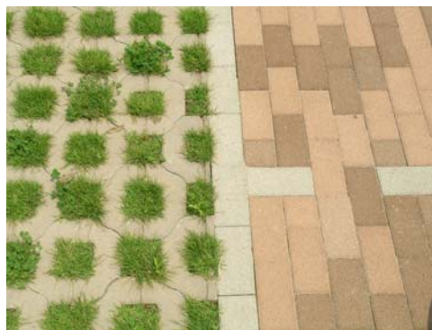
写真-8 熱画像撮影箇所の状況
