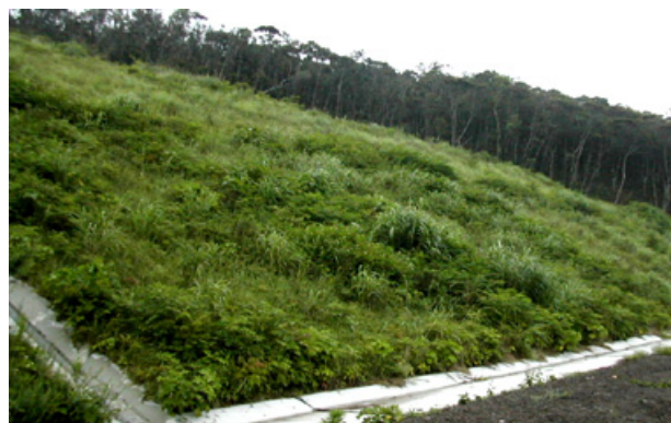
写真-5 施工後1年3ヶ月植生状況
