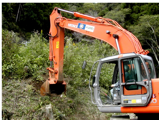
写真-1 バックホウによる表土を含む現地発生土の採取 (建設残土・真土などと表土の混合土の利用が可能)
