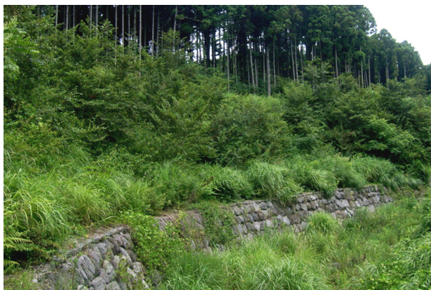
写真-4 植生状況（施工後5年6ヶ月）
