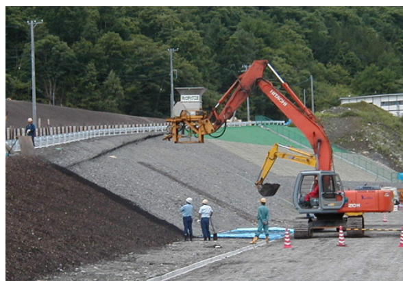
写真-2 撒きだし方式による生育基盤の造成
