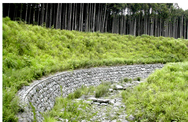
写真-3 植生状況（施工後2年6ヶ月）
