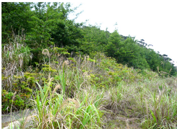
写真-7 施工後5年3ヶ月植生状況
