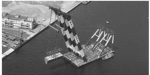
写真-3 Vブロック工法 (神戸港港島トンネル)
