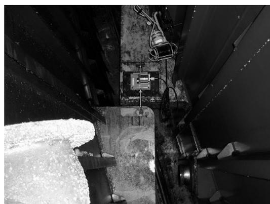
写真-6 水圧接合後の継手部分
