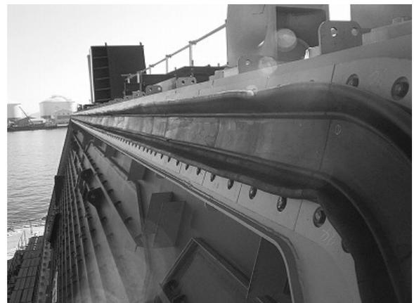
写真-5 伸縮性止水ゴムの取付・収納状況
