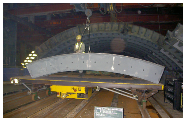
写真-6 鋼殻運搬用自走台車
