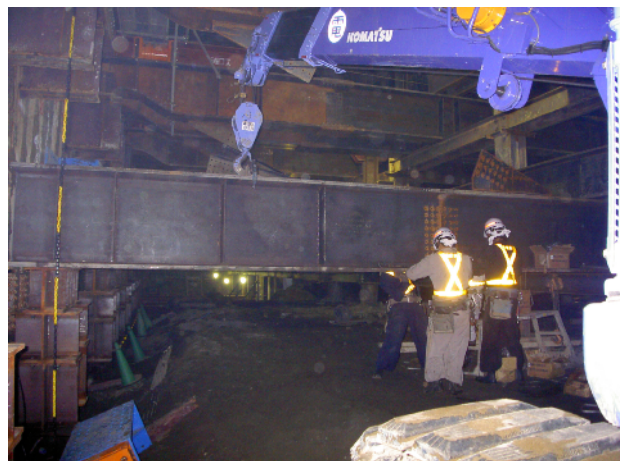
写真-3 特殊切梁施工状況
