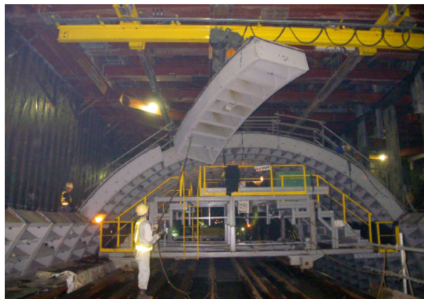
写真-5 天井クレーンおよび鋼殻撤去足場台車
