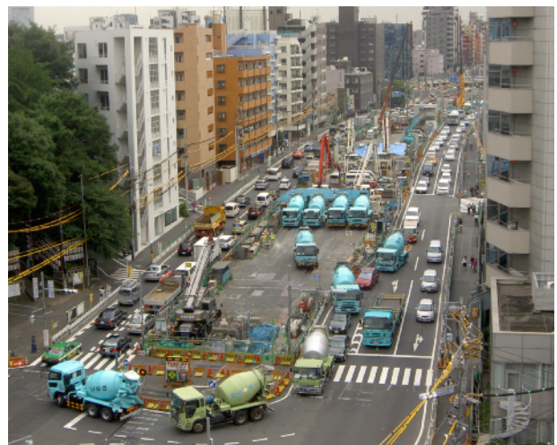
写真-1 工事状況（中央作業帯）
