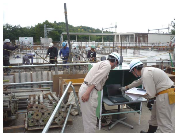
写真-4 管理用PCでの品質管理状況の確認
