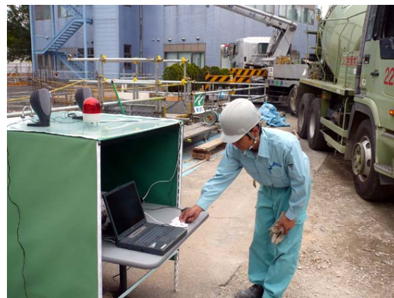
写真-3 打設現場での I C カードからパソコンへのデータの書き込み状況
