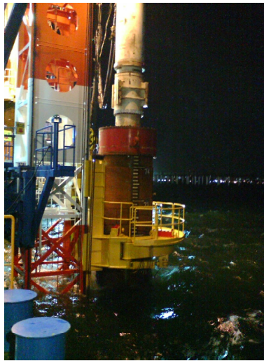
写真-6 打撃施工
