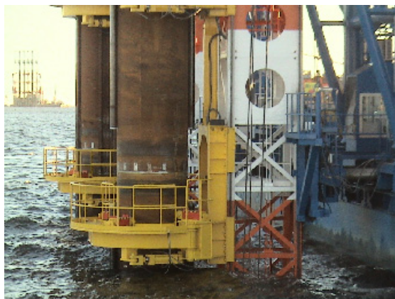
写真-9 継手接合後の状況
