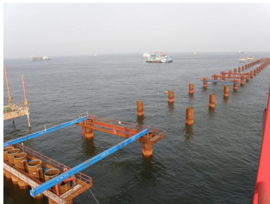
写真-10 格点部鋼管矢板施工完了後の状況
