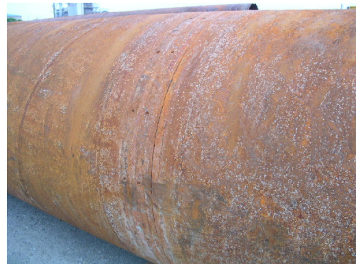
(a) 継手付近全景
