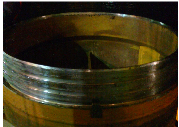
写真-7 振動施工後のピン継手
