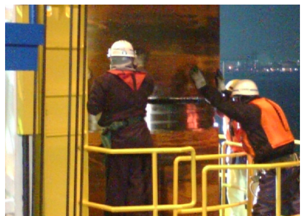
写真-8 機械式継手の嵌合作業状況
