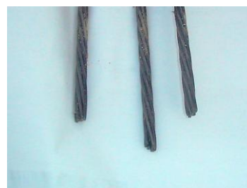
写真-6 P C 鋼線切断端状況
