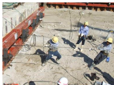
写真－9 人力による引抜き状況
