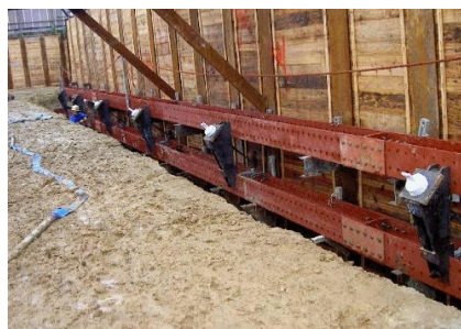
写真-11 FCD 耐荷体の建込み状況
