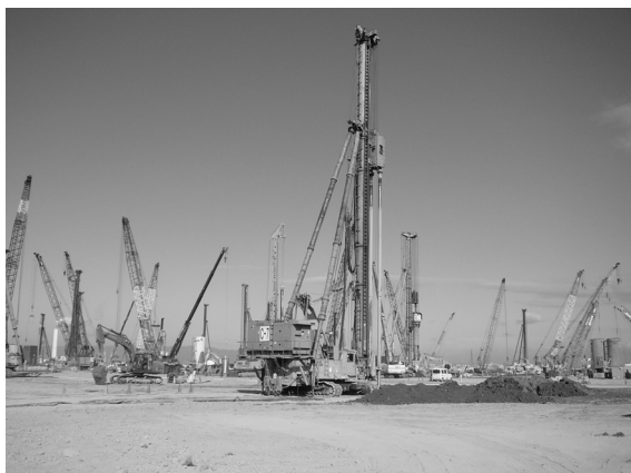
写真-11 施工状況
