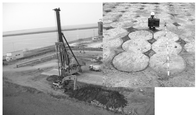
写真-9 施工状況及び出来形状
