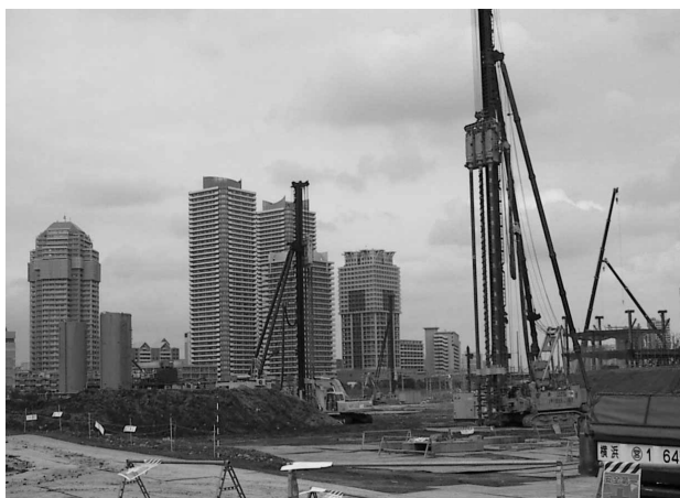
写真-10 施工状況
