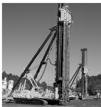
写真-1 施工機械の全景
