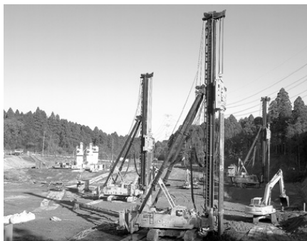
写真-6 施工状況
