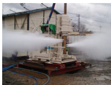
写真-13 気中噴射状況
