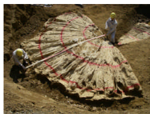
写真-3 半円状改良体
