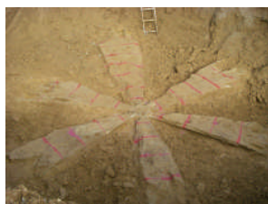
写真-2 多方向改良体
