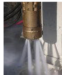
写真-15 ジェット削孔
