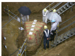
写真-11 遮水壁内の状況
