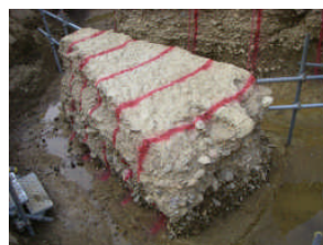
写真-8 砂礫改良体全景
