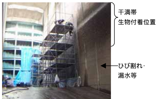
写真 - 4 実コンクリートでの現地試験施工状況
