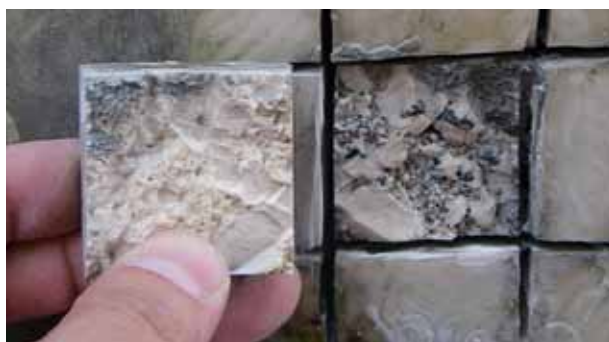
写真 - 5 断面修復材での破断 (実コンクリートでの現地試験施工)
