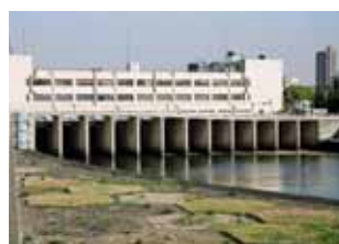
(a)排水機場全景
