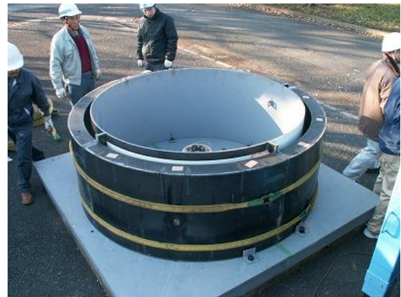
写真15 鋼製セグメント組立
