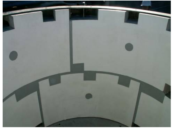
写真18 合成セグメント組立完了
