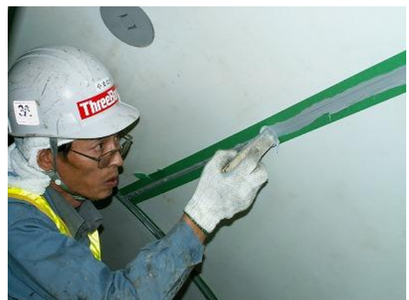
写真12 目地材充填状況
