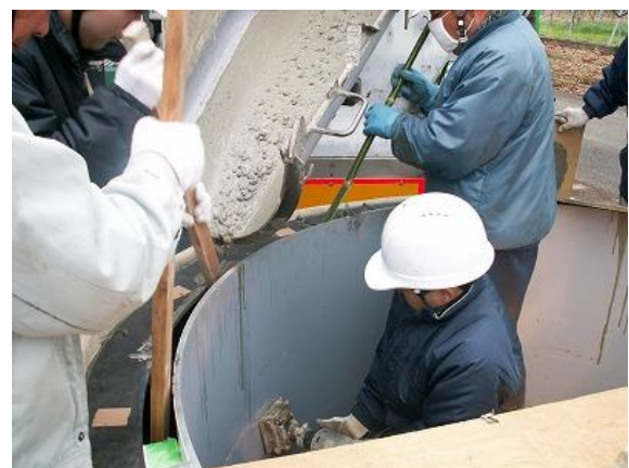
写真16 高流動コンクリート打設状況
