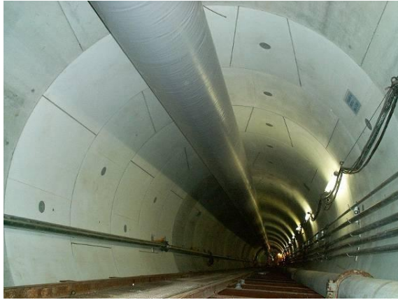
写真13 目地材充填状況
