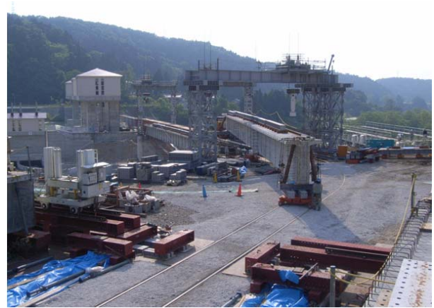
写真-7 桁移動（曲線部）
