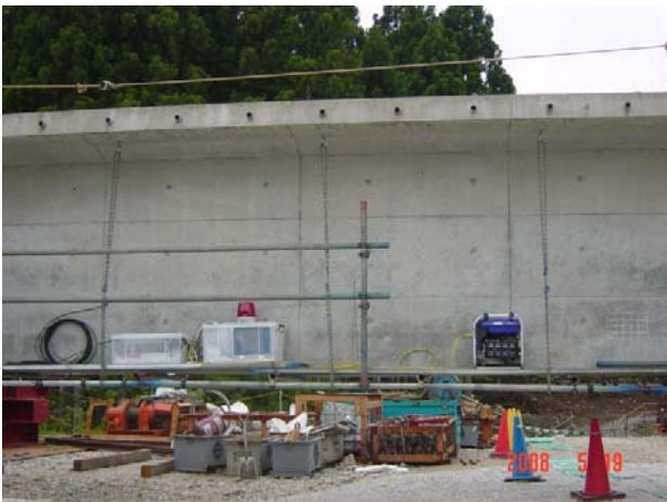
写真-6 計測装置の設置状況
