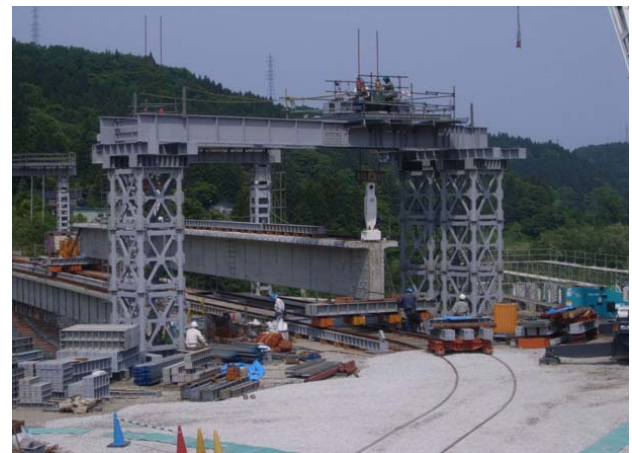
写真-8 桁移動（曲線部完了）
