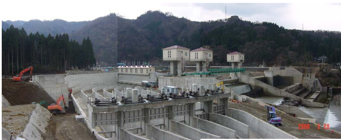
写真-1 改修工事中の横江頭首工
