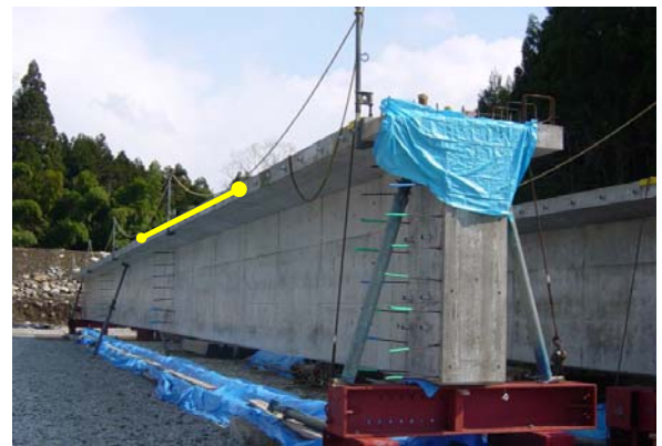
写真-4 PC 桁とセンサーの取り付け位置
