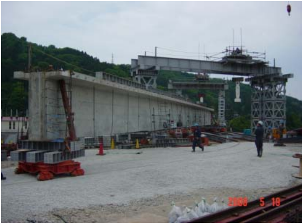
写真-2 全回転型重量台車（PC 桁の前後端）
