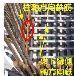
写真-16 梁固定状況
