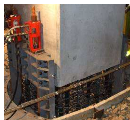
写真-12 転倒防止装置の設置
