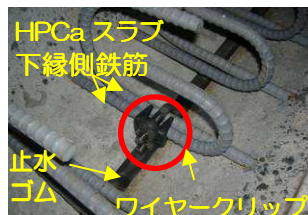
写真-18 スラブ間固定状況
