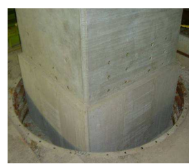
写真-14 柱構築完了
