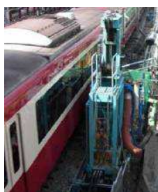
写真-2 狭隘施工型杭打機
