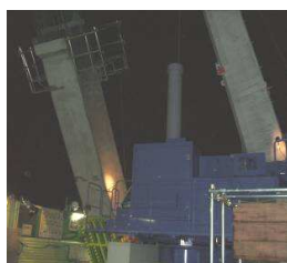
写真-10 柱建起し状況
