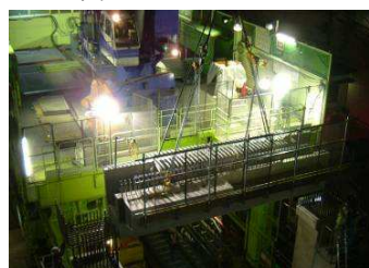
写真-15 梁架設状況
