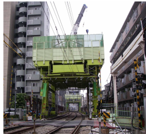
写真-3 移動式直接高架施工機
