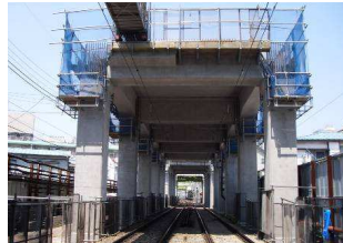
写真-20 部材架設完了
