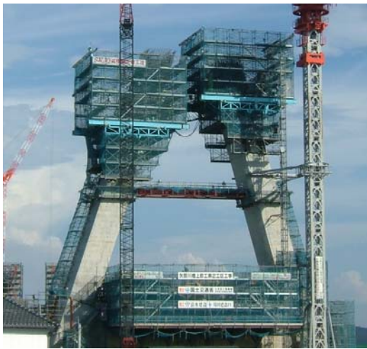
写真-1 SKJ0工法施工状況
