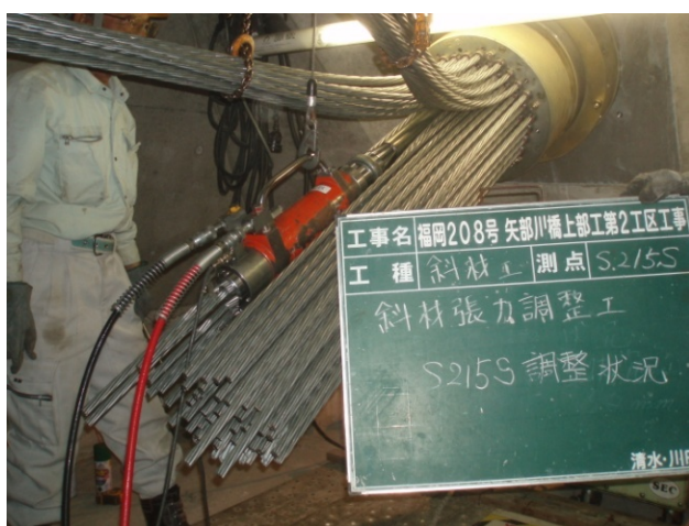
写真-4 シングルストランドジャッキによる調整状況
