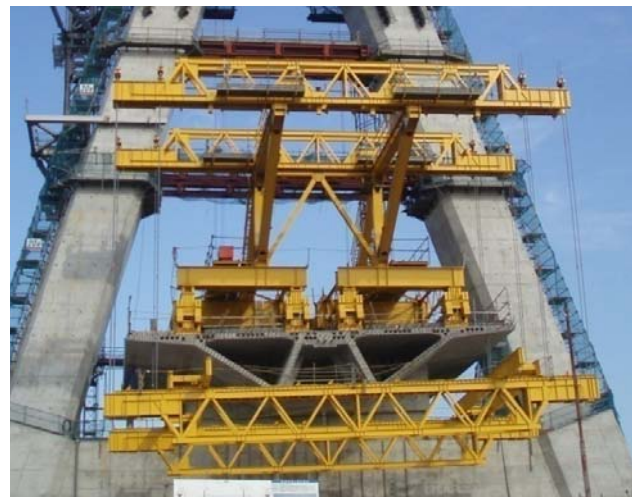
写真-3 超大型移動作業車組立て状況
