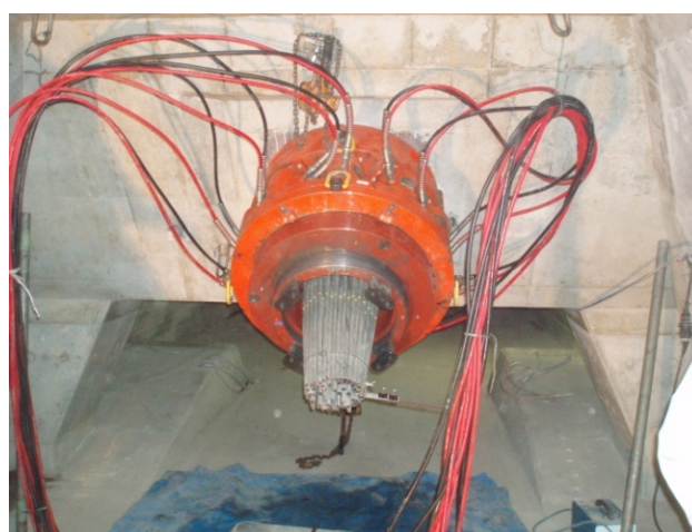
写真-5 マルチストランドジャッキによる調整状況
