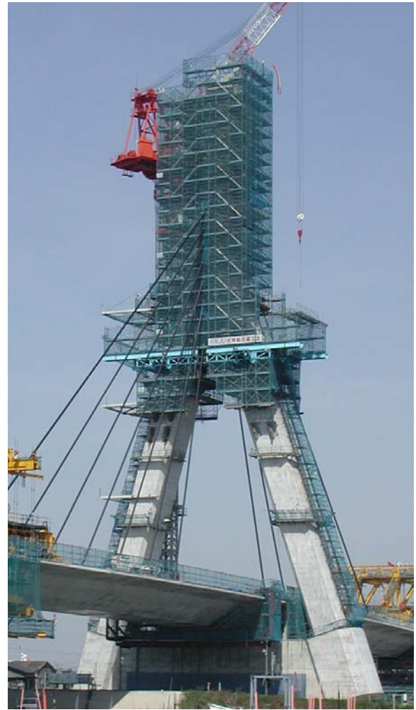
写真-2 主塔頂部施工状況
