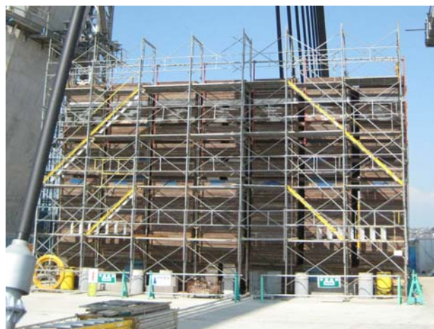
写真-6 鉄板載荷状況 3,800t
