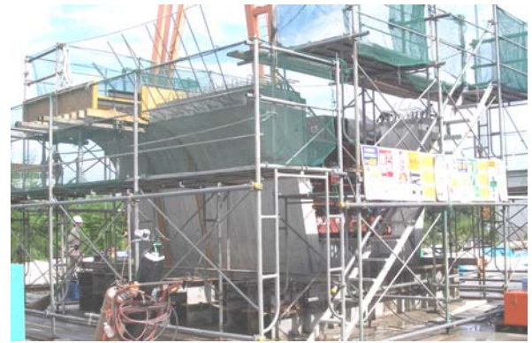
写真-7 実物大模型載荷試験状況
