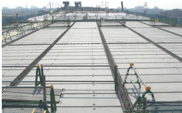
写真-10 床版施工状況 (P C 板敷設時)
