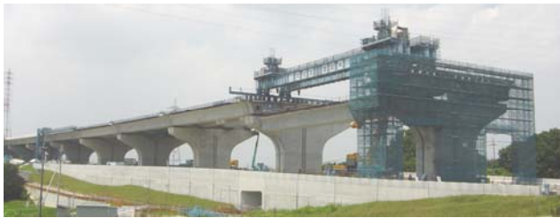
写真-6 U桁吊上げ状況②
