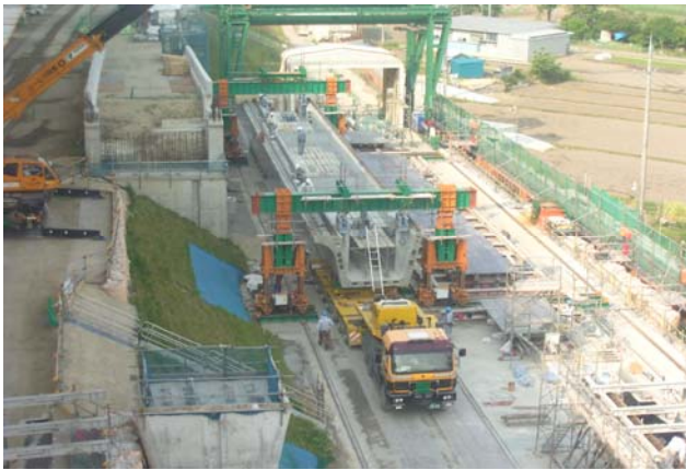
写真-3 U桁の積み込み状況
