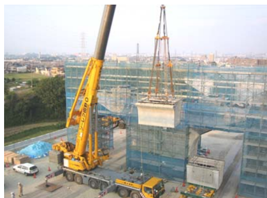
写真-1 プレキャスト柱頭部桁架設状況
