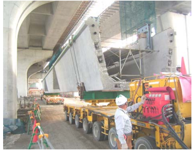
写真-4 U桁の場内運搬状況
