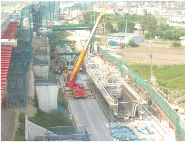
写真-2 U桁製作ヤード全景
