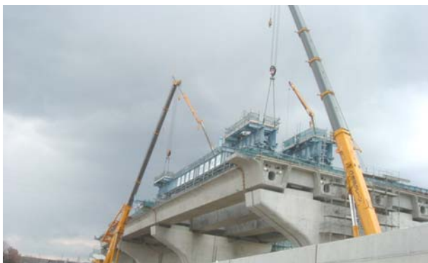
写真-9 リフティングガーダー吊上げ状況
