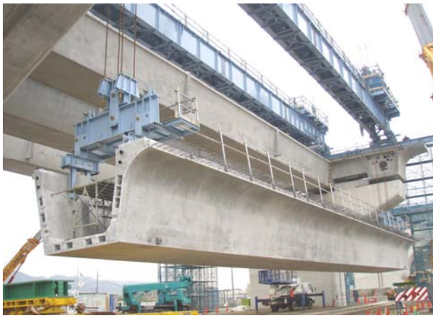
写真-5 U桁吊上げ状況①
