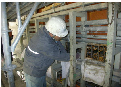
写真-6 打設①から締固め状況
