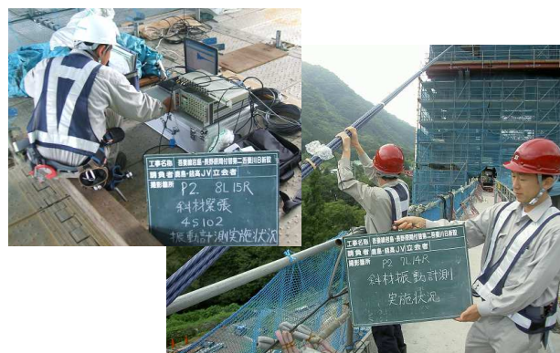
写真-11 1次斜材振動計測状況
