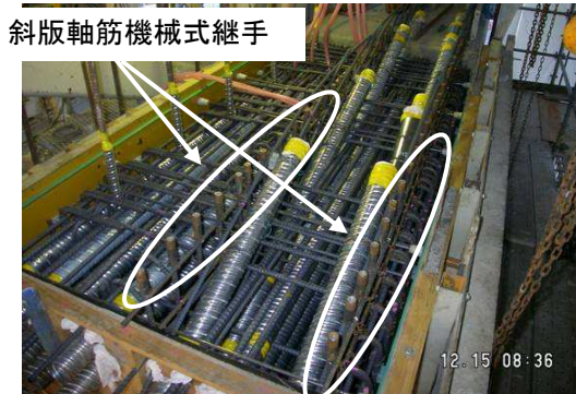
写真-4 斜版取付け部分の配筋状況
