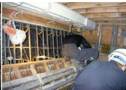
写真-7 打設窓②から締固め状況
