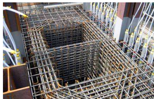
写真-2 P 2 橋脚脚頭部配筋状況
