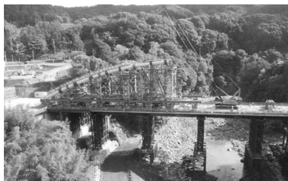
写真-1 アーチリブ・タイ組立状況
