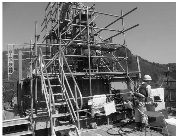
写真-2 リフトアップ装置
