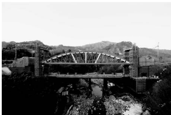
写真-6 第1回リフトアップ完了写真
