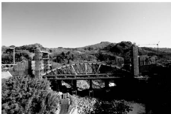
写真-5 第1回リフトアップ前状況写真
