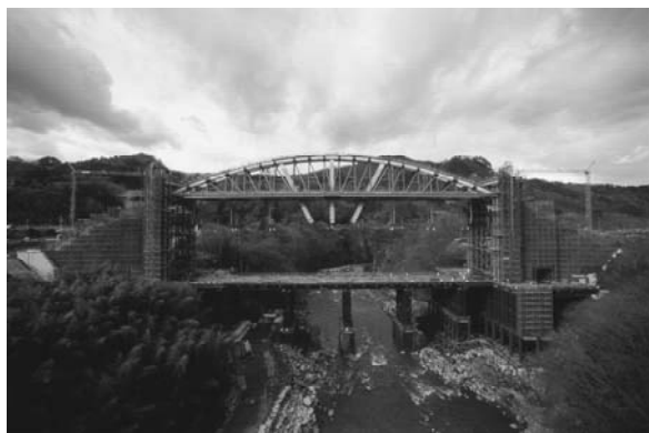
写真-7 第2回リフトアップ完了写真
