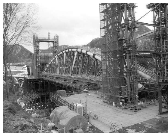
写真-3 リフトアップタワー状況写真
