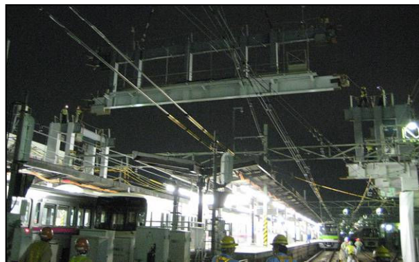
写真-7 大梁架設状況
