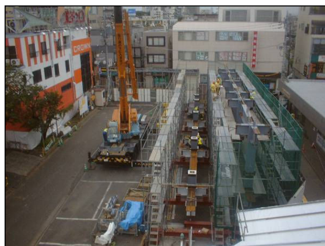
写真-9 桁の地組状況
