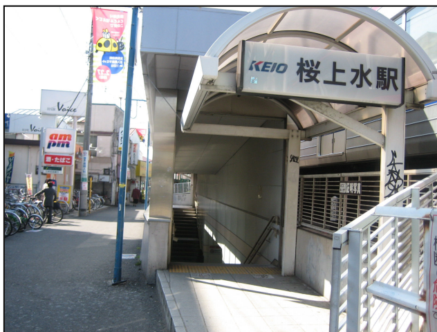
写真-6 駅周辺状況
