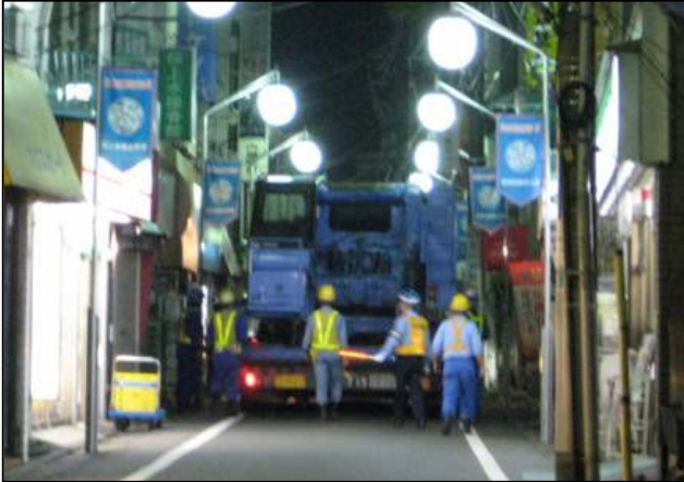
写真-10 550tクレーン搬入状況
