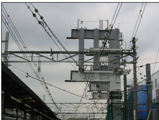
写真-8 柱ブロック立柱状況
