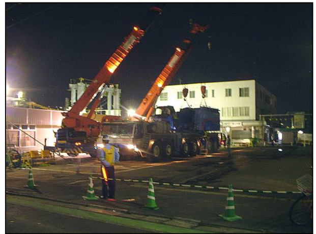
写真-11 550tクレーン組立状況
