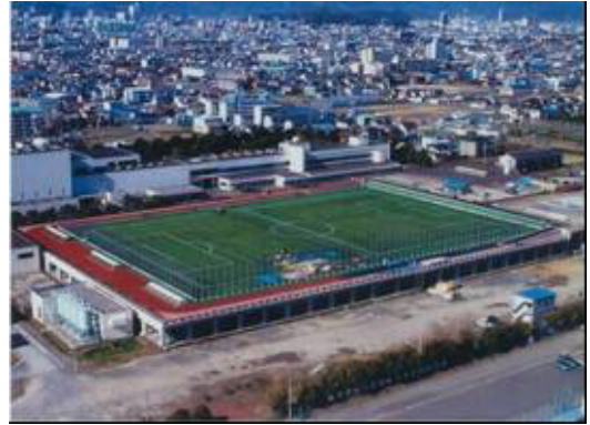
写真-6 中島浄化センター全景
