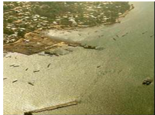
写真-3 港湾施設の地震・津波の二重被害
