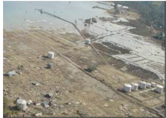
写真-2 石油ターミナルでの貯油タンクの漂流
