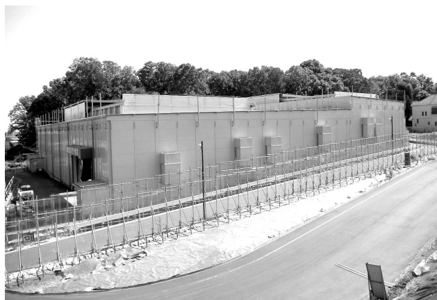
写真-4 防音ハウス設置（起点側立坑）
