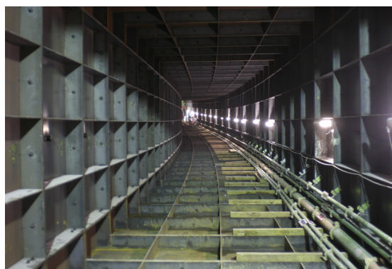
写真-4 ハーモニカ推進完了後の坑内
