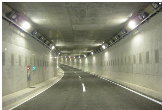
写真-5 供用前のハーモニカ施工部
