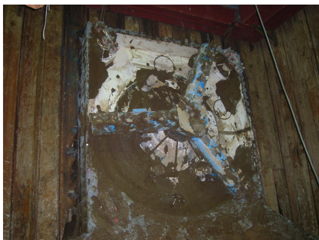
写真-3 ハーモニカ掘削機推進完了状況
