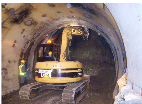
写真-4 拡幅部の掘削状況 (1)
