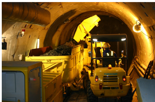
写真-2 セグメント内での作業状況
