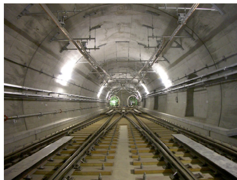
写真-7 到達部単線断面をのぞむ
