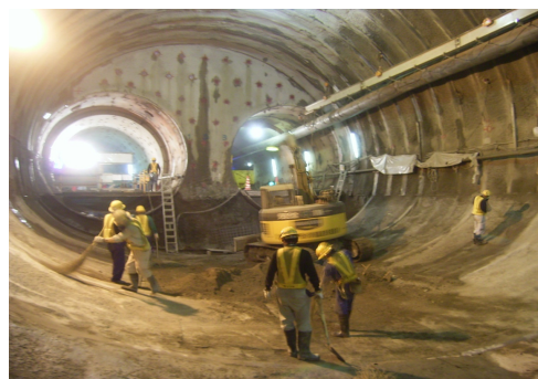
写真-6 拡幅部の掘削状況 (3)
