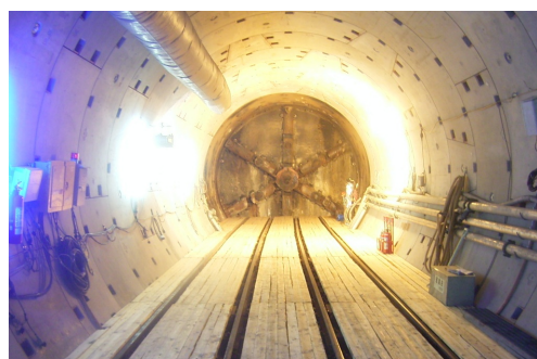
写真-3 木製重機足場
