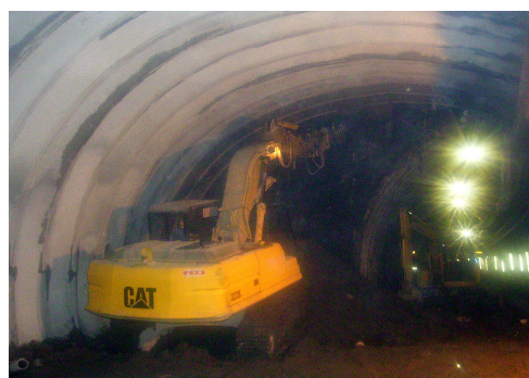
写真-5 拡幅部の掘削状況 (2)
