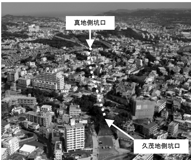
写真-1 全景写真 (着工前)
