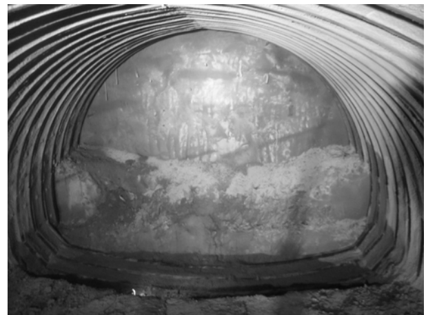
写真-4 インバート閉合完了
