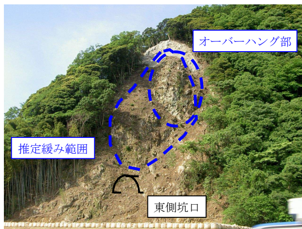
写真-3 東側坑口斜面の全景
