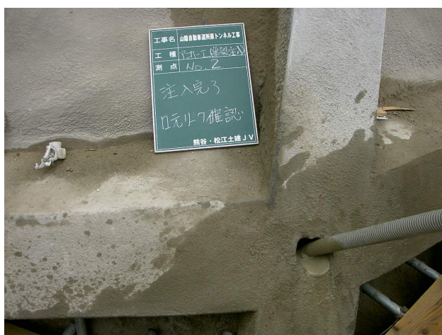
写真-6 セメントミルク充填状況
