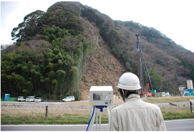
写真-4 3Dレーザー計測状況
