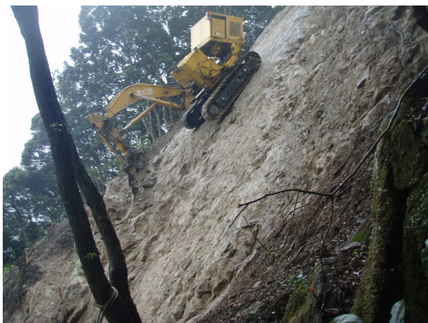
写真-5 高所岩盤掘削機掘削状況
