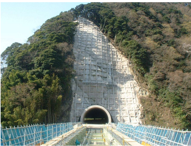
写真-8 のり面对策工全景
