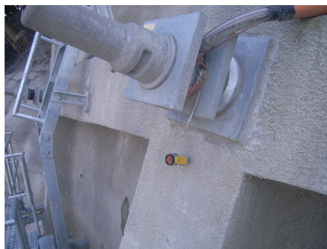
写真-7 アンカー荷重計およびプリズムの設置状況
