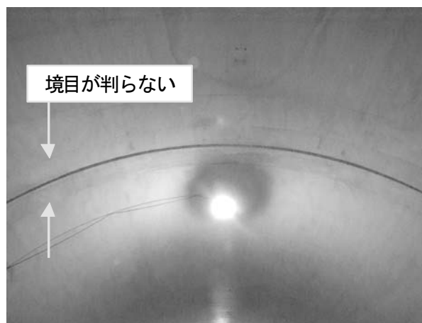
写真-5 脱型 4 週経過後の出来形
