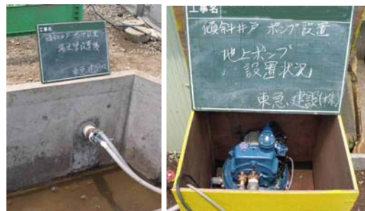
写真-11 揚水状況
