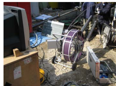
写真-9 井戸管内確認状況
