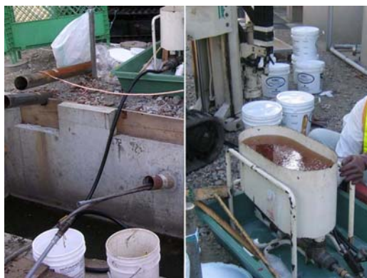
写真-13 薬剤注入状況
