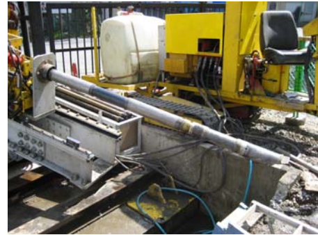
写真-8 井戸管削孔（大型マシン）
