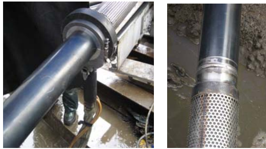
写真-6 自動溶接状況
