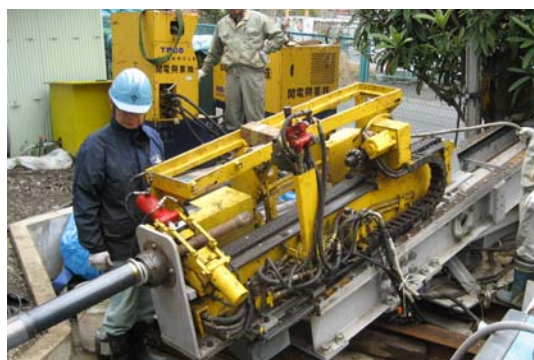
写真-2 大型マシン
