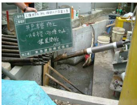
写真-7 井戸管削孔（小型マシン）
