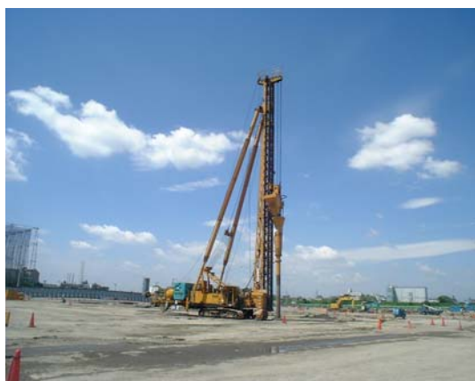
写真-8 グラベルドレーン施工状況
