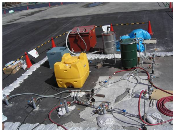
写真-2 第2回実証実験状況
