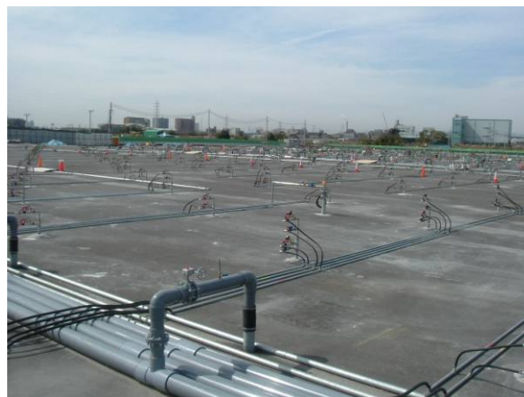
写真-3 施工状況全景
