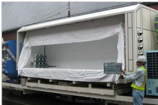
写真-3 養生ブース（クイックブース）取付け状況
