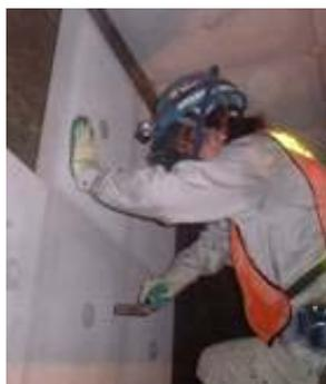
写真-8 吸音板施工状況
