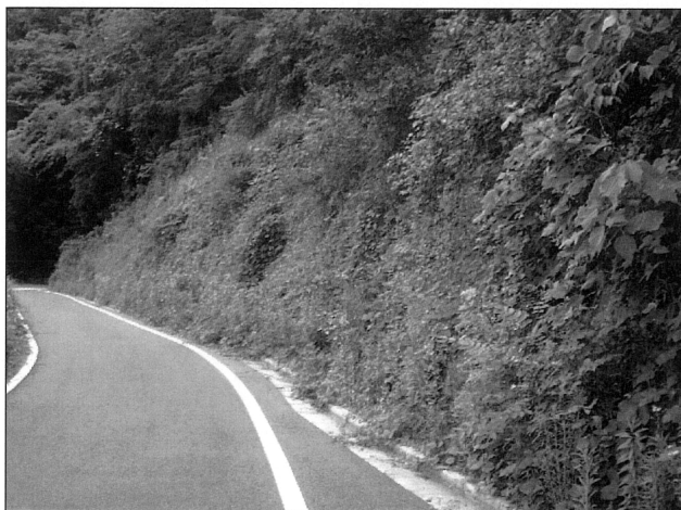
写真-8 無播種による施工事例（施工後3年経過）
